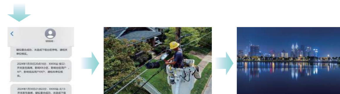
实时推送停电信息给检修人员 抢修人员收到短信后第一时间前往现场 抢修结束 恢复供电
